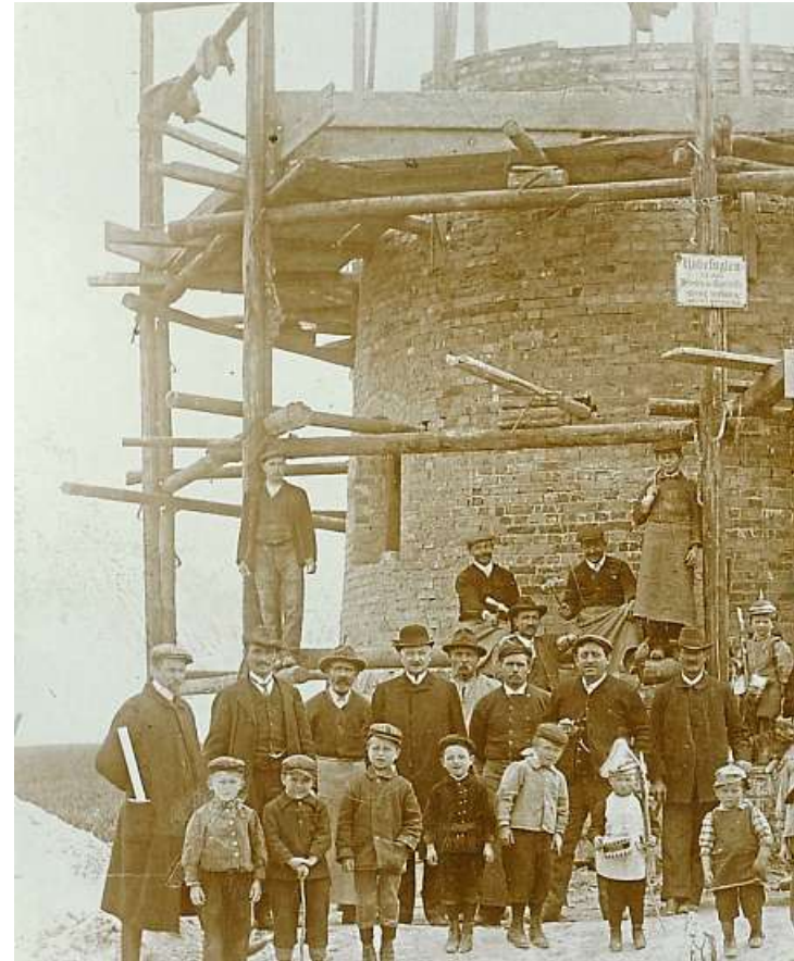
Der Igstader Wasserturm wird vermutlich das Cover des Kalenders des Heim
